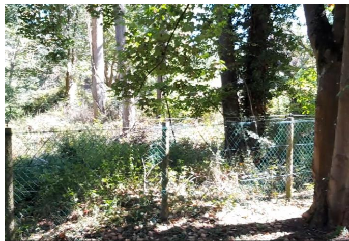
Figure 4-31 – Clôture existante de délimitation des terrains du SIAVB
